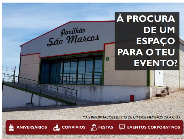
Figura 3 - Pavilhão de São Marcos.
